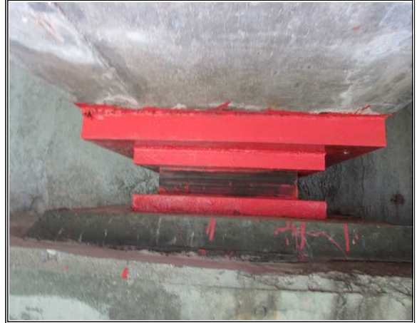
위 치 백옥포교(인천) 내 용 교량받침 전경
