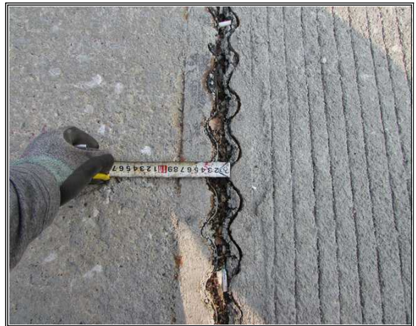
위 치 백옥포교(인천) 내 용 신축이음 유간 측정
