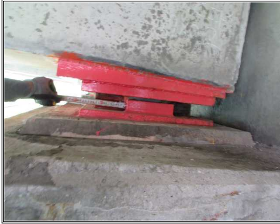
위 치 백옥포교(인천) 내 용 교량받침 이동량 측정
