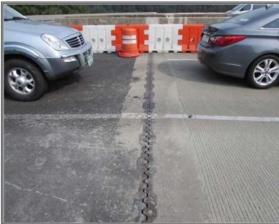
위 치 백옥포교(인천) 내 용 신축이음 전경
