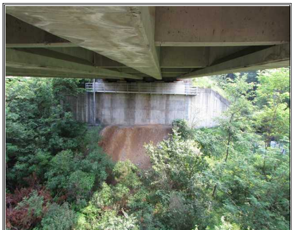
위 치 백옥포교(인천) 내 용 교대 전경
