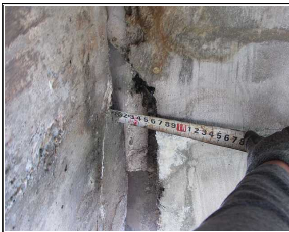
위 치 백옥포교(인천) 내 용 바닥판 유간 측정
