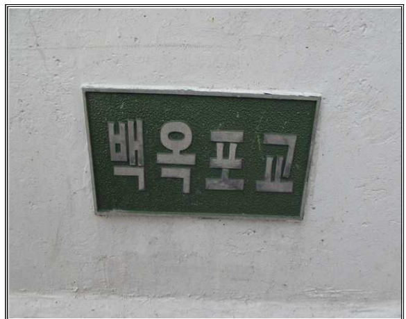
위 치 백옥포교(인천) 내 용 교명판 전경
