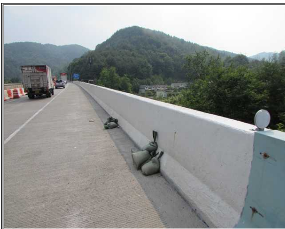
위 치 백옥포교(인천) 내 용 난간 및 연석 전경
