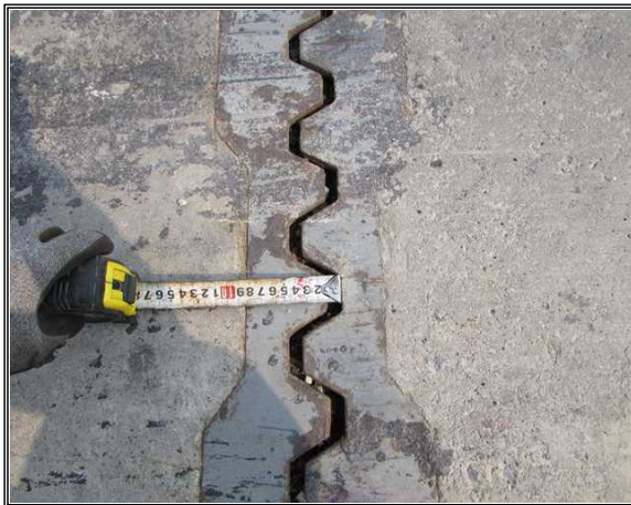
위 치 백옥포교(인천) 내 용 신축이음 유간 측정
