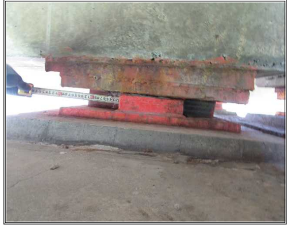
위 치 백옥포교(인천) 내 용 교량받침 이동량 측정
