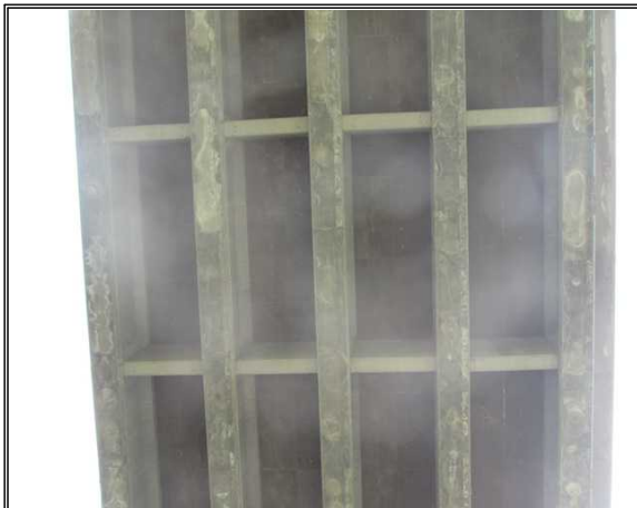
위 치 백옥포교(인천) 내 용 바닥판 하면 전경
