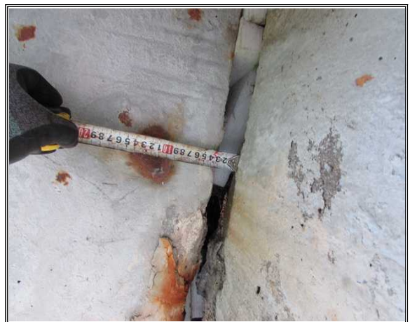
위 치 백옥포교(인천) 내 용 바닥판 유간 측정
