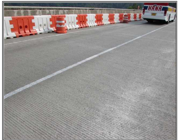
위 치 백옥포교(인천) 내 용 교면포장 전경
