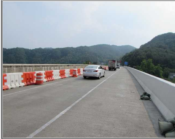
위 치 백옥포교(인천) 내 용 상부 전경
