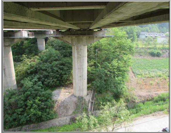
위 치 백옥포교(인천) 내 용 하부 전경
